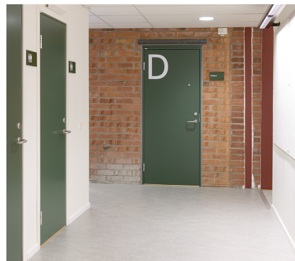
Massivdører i 28 dB til toaletter, og Daloc-dør med lydklasse 43 dB til danseundervisningsrom
