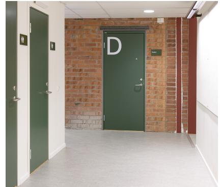
Massivdører i 28 dB til toaletter, og Daloc-dør med lydklasse 43 dB til danseundervisningsrom
