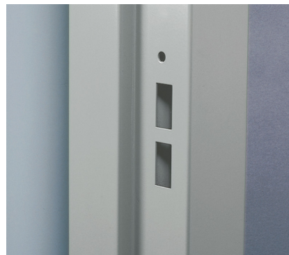
Sluttstykke med sikkerhetsbolt.
