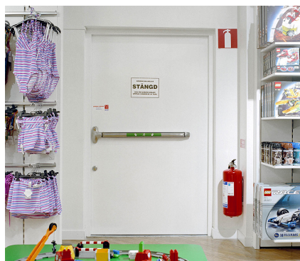
Sikkerhetsdør med panikkskåte, magnetkontakt og mikrobryter i lås er et vanlig syn i butikker.
